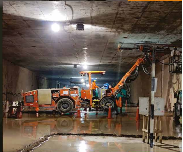
Instalación de micropilotes para el acceso al andén en la línea 2 del metro de Lima estación 26 Av Javier Prado.
